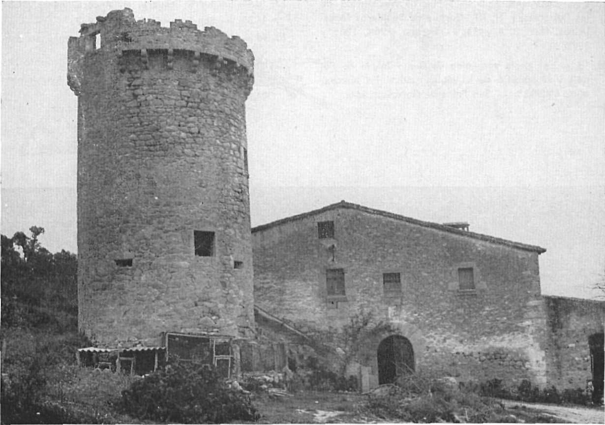
CASTELL D'ARO. — Torre Seguera, en el manso "Xai" o "Cal Rei". Interesantísimo ejemplar de las torres de defensa denominadas "de moros", típicas de la zona litoral. Rematada con matacanes. Edificada en el siglo XVI para defensa de piratas bereberes. Para su total reintegración nada más le faltaría macizar el hueco moderno.
