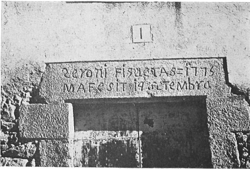
CASTELL D'ARO.— Dintel de Geroni Figueras, datado en 1775 en la calle de la Carretera. Mide 2 por 0,48 m. (Fot. Luis Esteva)
