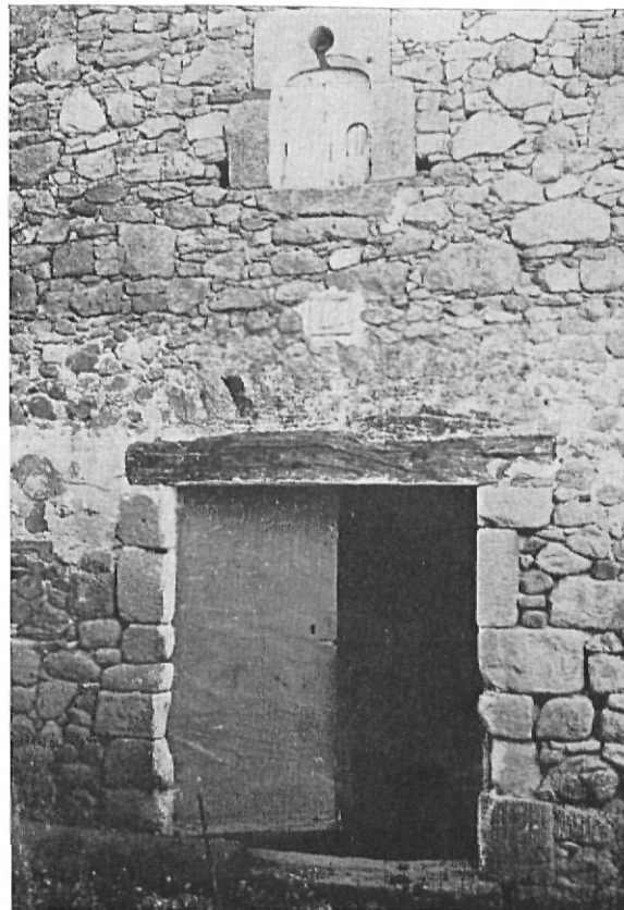
CASTELL D'ARO.— Ventana gótica simple, en la calle Mayor. Siglo XIV (Fot. Luis Esteva)
