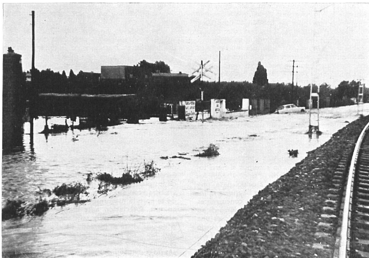
Vista de la zona completamente inundada
