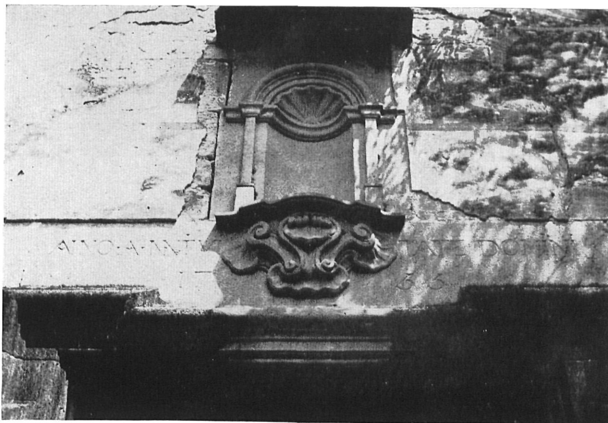
SANTA PAU. — Santuari dels Ares: Dintel de la porta barroca de la fachada: ANNO. A. NATIVI / TATE DOMINI - 1755. Hornacina y restos de estucos contemporáneos.
