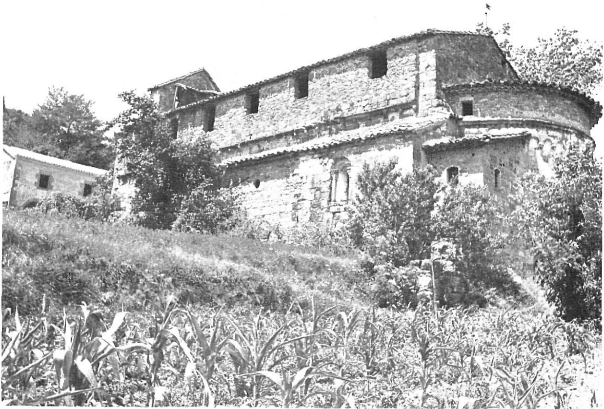
SANTA PAU. — Santuari dels Arcs. Costado lateral Sur de la iglesia en el que se aprecia el paso al camarín, junto al ábside, hoy ya derribado. El ventanal románico de la epístola y el recoveco de la iglesia y ábside. La espadaña moderna; y a la izquierda, dependencias de la hospedería. (Foto Aleu)
