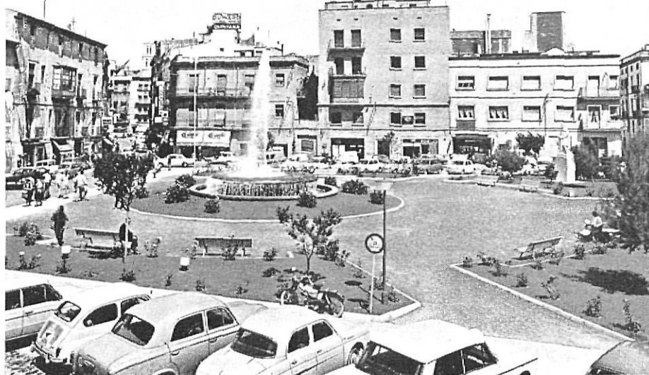
Terreno en donde estuvo emplazado parte del antiguo hospital, hoy plaza pública
