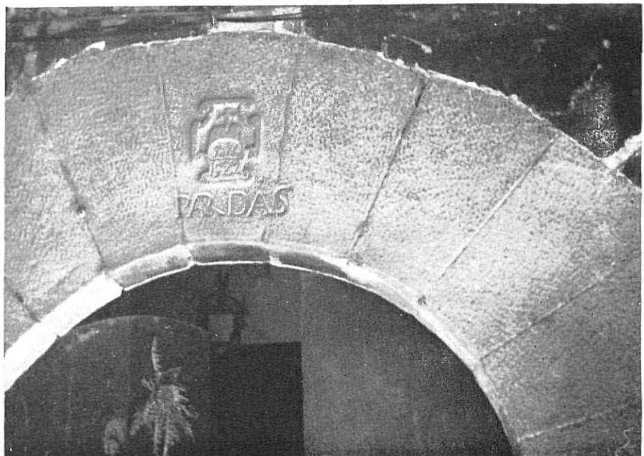
SANTA PAU. — Puerta dovelada en la Plaça Major.
