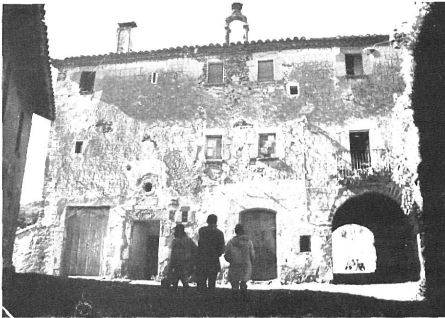
SANTA PAU. — Antiguo Hospital de la villa y capilla de Sant Roc y Sant Sebastià. Barroca.
