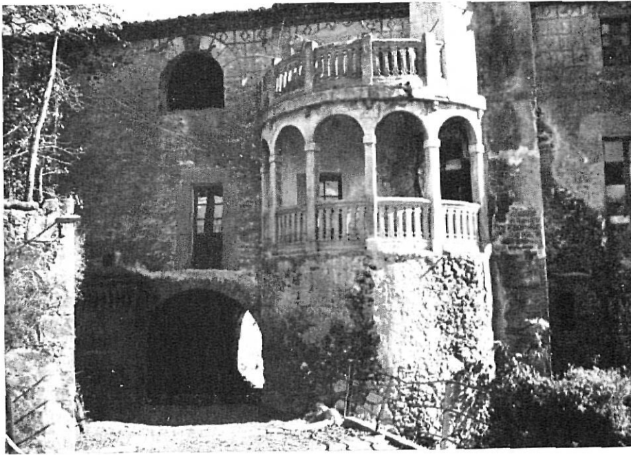
SANTA PAU. — Parte trasera del Hospital, con tribuna moderna encima del ábside de la capilla.
