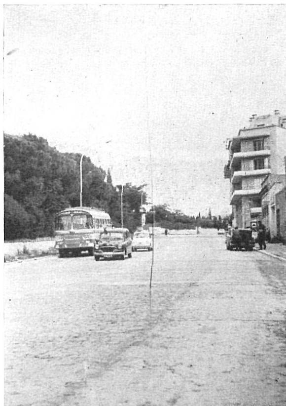
Vista de la actual variante de la carretera Nacional
