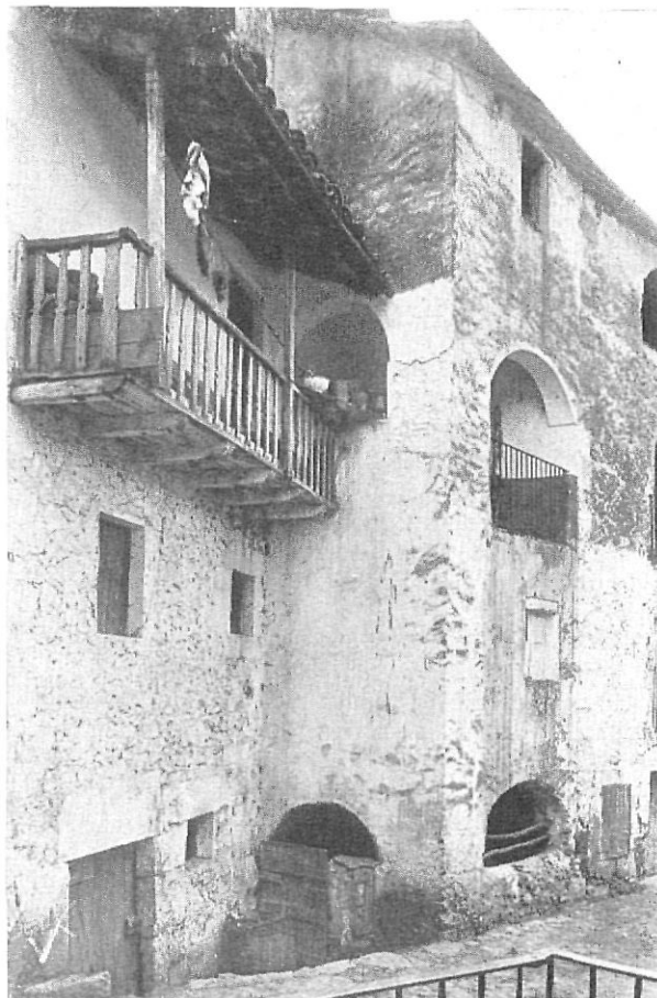
SANTA PAU. — Calle de entrada por el camino de Olot. Estructuras actualmente transformadas
