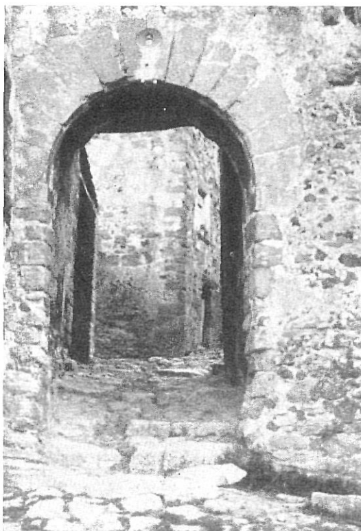
SANTA PAU. — Portal del Mar en el recinto amurallado de Vila Vella, en el costado de levante. La puerta debió poseer rastrillo. En la clave del arco empotrada una jarola de un gusto desgraciado. (Foto M. Oliva Prat).
