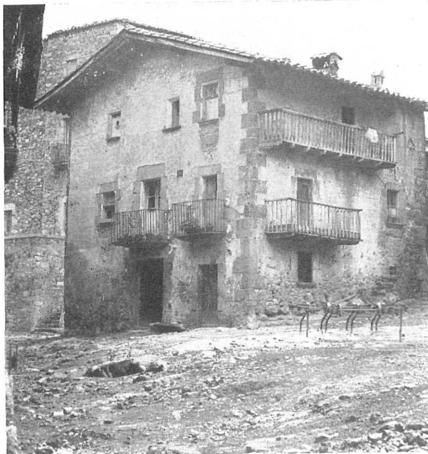
SANTA PAU. — Típica casa de montaña, en la plaza Fuertes aleros en voladizo y balconadas de madera. Es uno de los edificios de mejor carácter. (Foto Dr. J. M. Bohigas)
