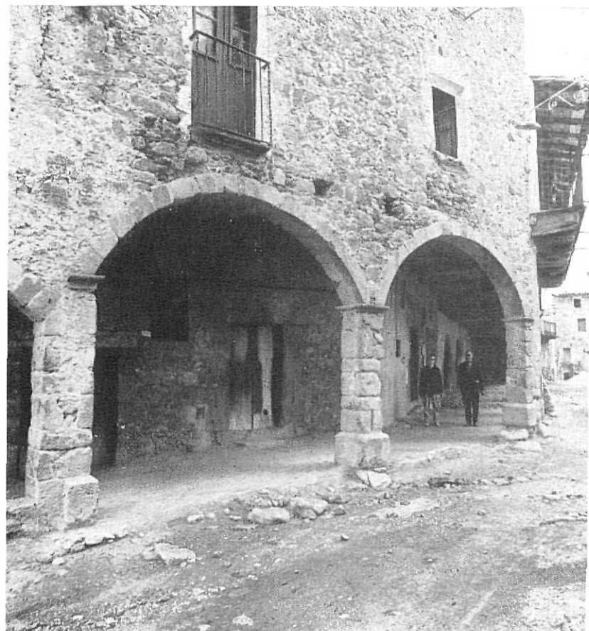
SANTA PAU. — Firal dels Bous. Vista general de los pórticos de poniente. Corona a la planta noble de los edificios los cabos de vigas de los saledizos y balcones hoy cercenados
