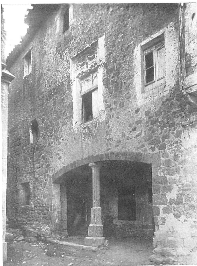
SANTA PAU. — Detalle de uno de los arcos rebajados con refuerzo posterior y ventanal gótico en yeso
