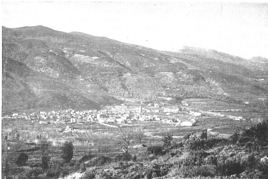
Fig. 1. — Vista de Amer desde la Torre de St. Climent.
