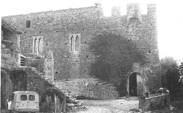
Fachada principal del castillo
