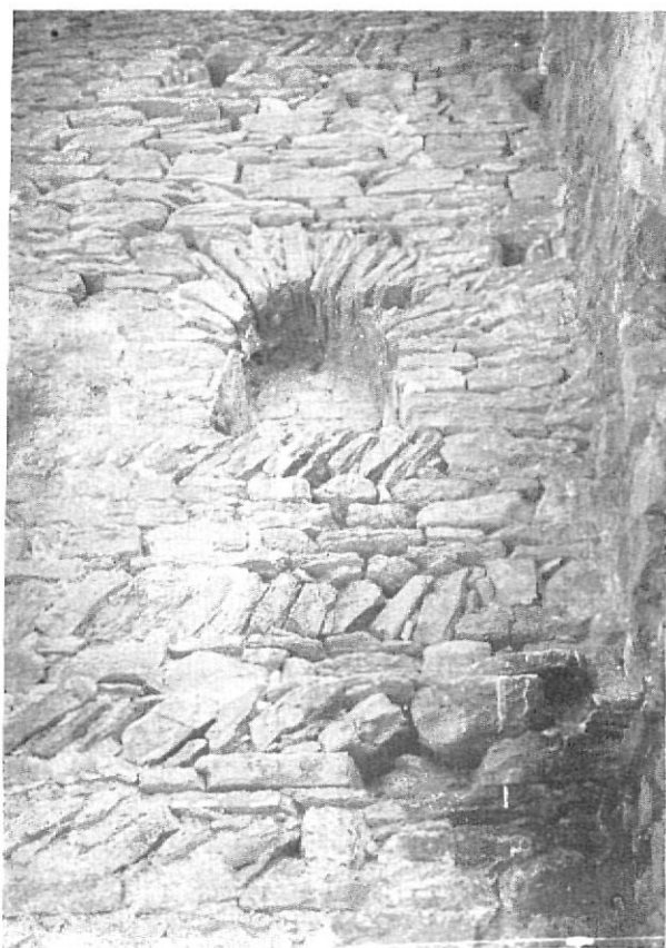
SANT JULIA DE RAMIS. — Castillo de Montagut. Detalle del "opus spicatum" en el paramento interior de la antigua torre, luego incorporada a construcciones posteriores y convertida en Torre del homenaje
