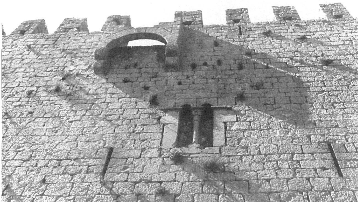
Fachada principal con su remate almenado, matacán y ventana románica
