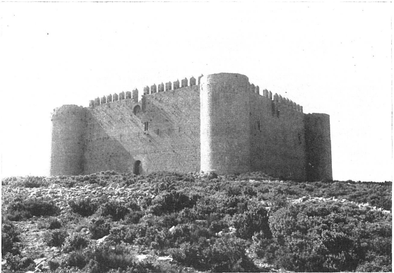
Vista general del Castillo de Montgrí
