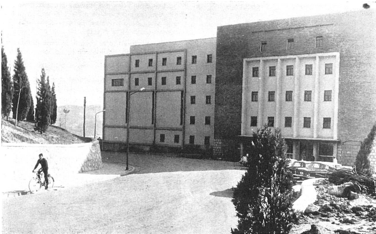
Fachada (Foto Sans)
