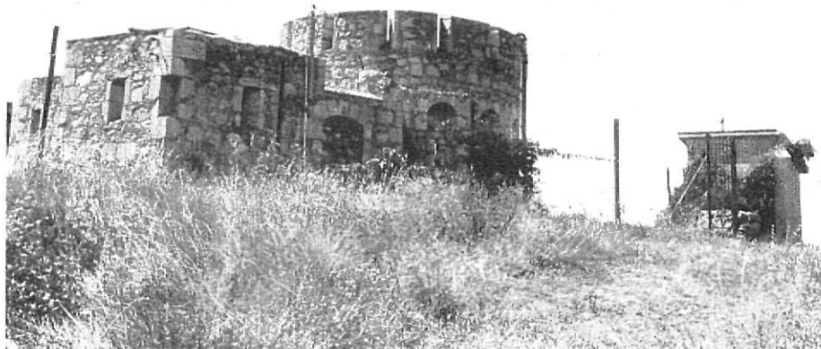
La torre de Alfonso XII está construida en gran parte con piedra de sillería y tiene aspecto de un pequeño fuerte, más que de una simple torre
