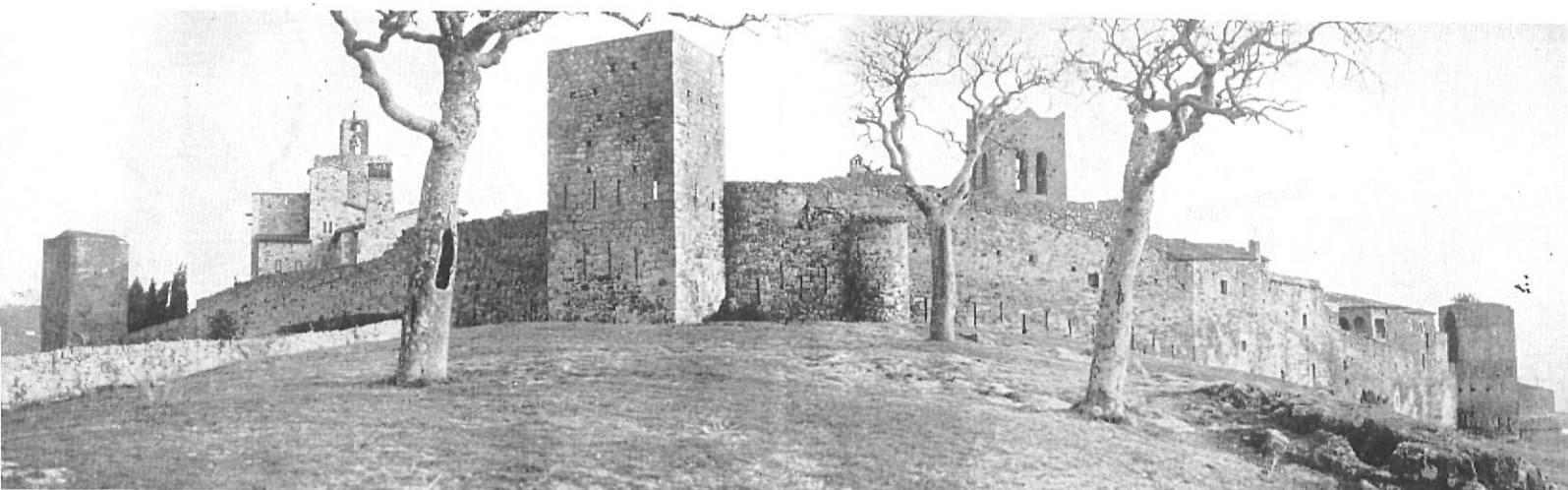
PALS. — Panorámica del recinto medieval del Pedró
