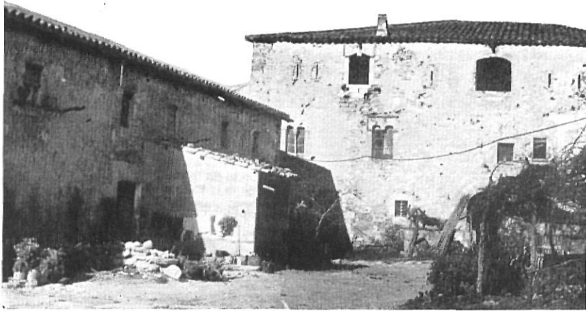
Can Puig de la Bella Casa. — Típica masía fortificada, centro de un barrio.
