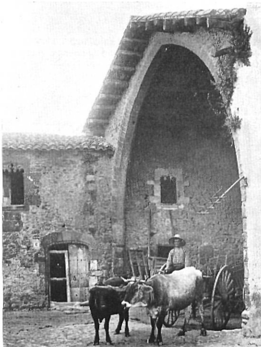
ULLASTRET. Arco de acceso a la logia o pórtico medieval y casa del fondo, estado en 1918. (Fotogr. Arxiu Mas)
