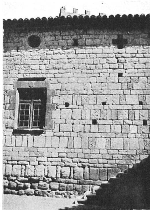
PERATALLADA - Muro meridional del aula maior, con el característico despiezo de sillares verticales, obra muy primitiva. El ventanal renacentista es posterior; y ostenta en el dintel escudo de la Casa de Cruïlles. (Fotografía del autor)
