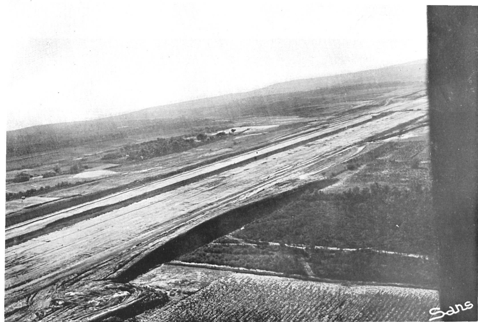
Mientras se efectuaban las obras, así se veía el aeropuerto desde el helicóptero en que volaron los informadores.
