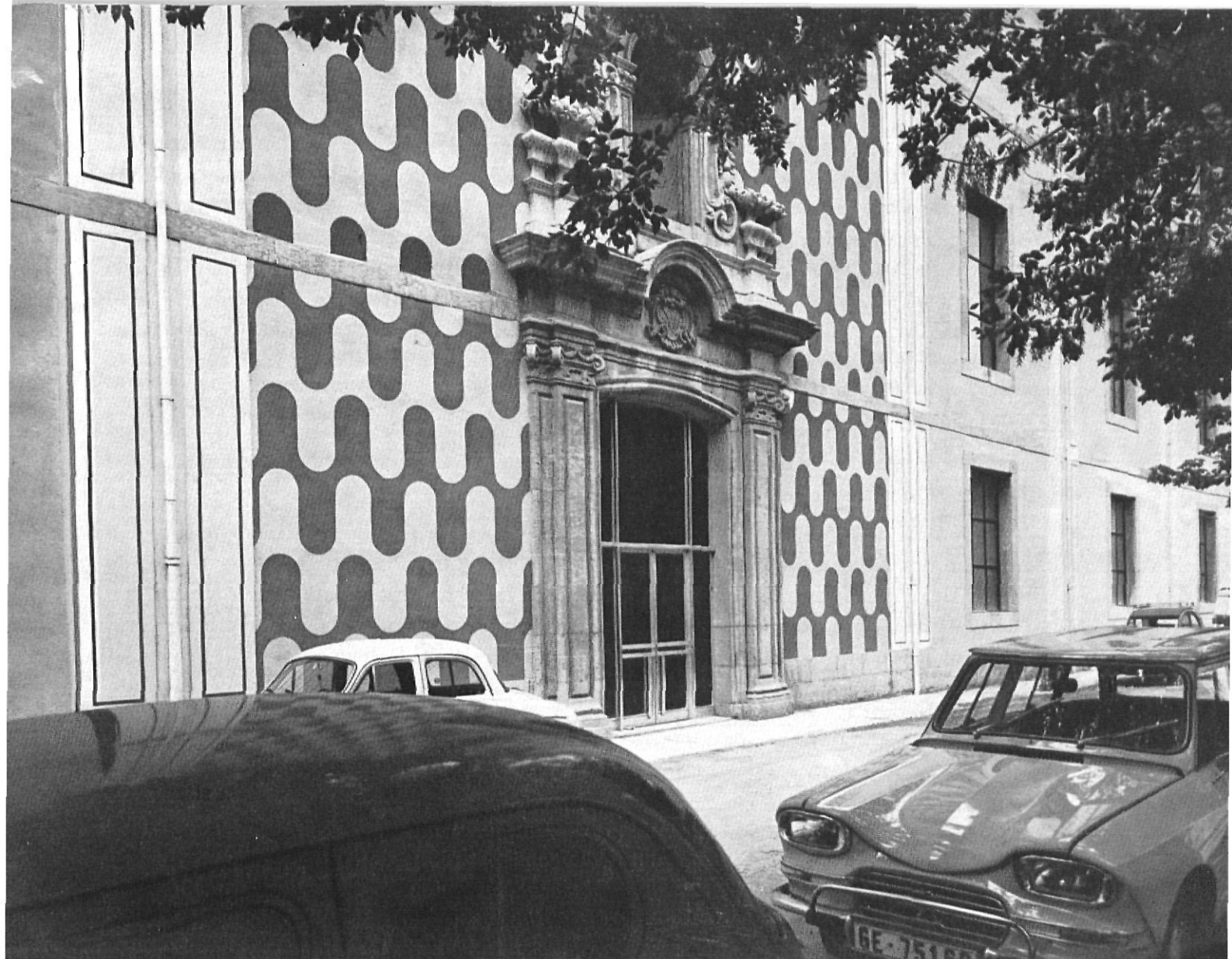
Fachada principal de la "Casa de Cultura".
