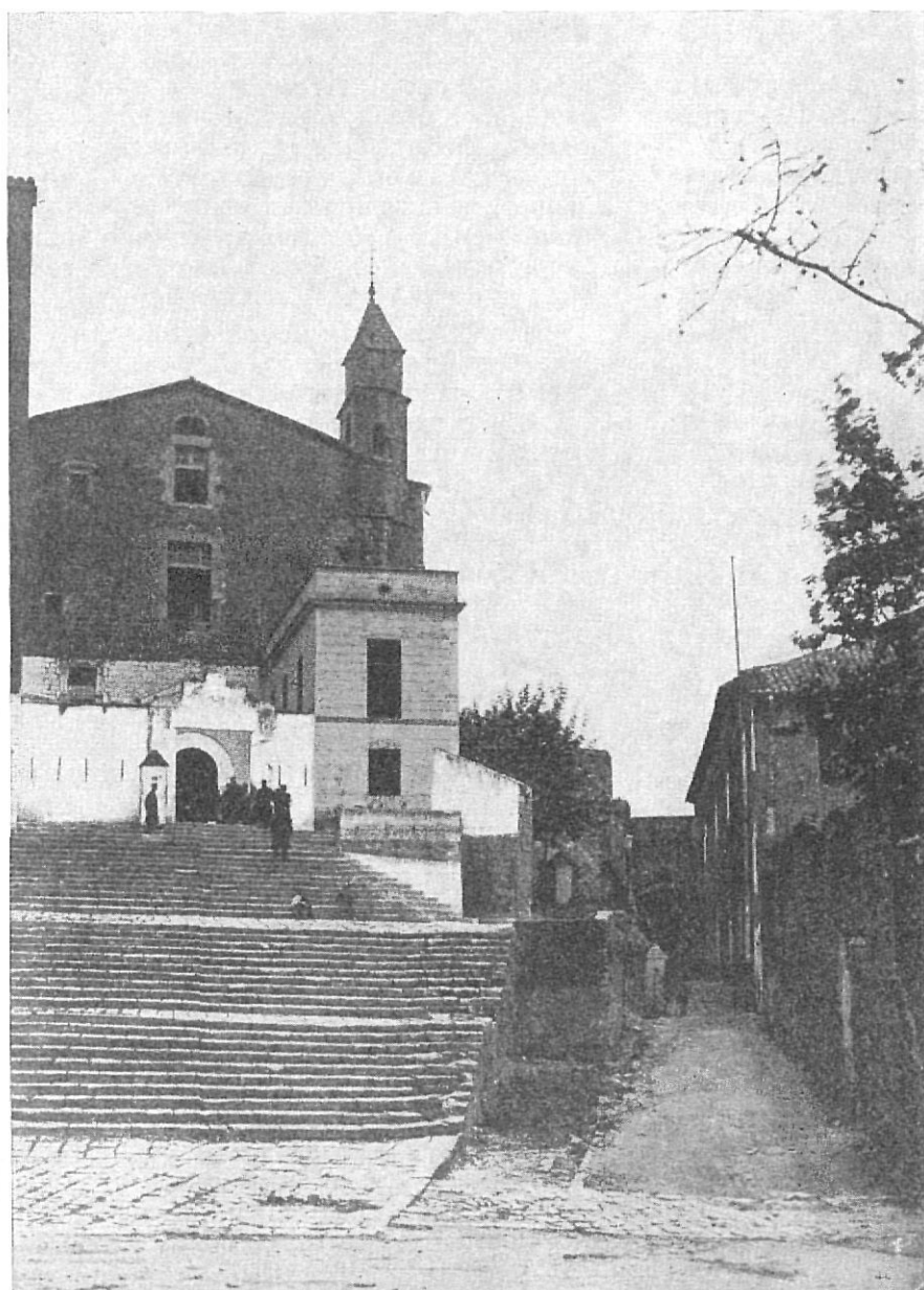
Cuartel de Santo Domingo, antes convento. Aspecto que ofrecía su fachada a comienzos del siglo actual
