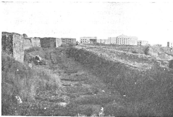
Vista lado Oeste.
