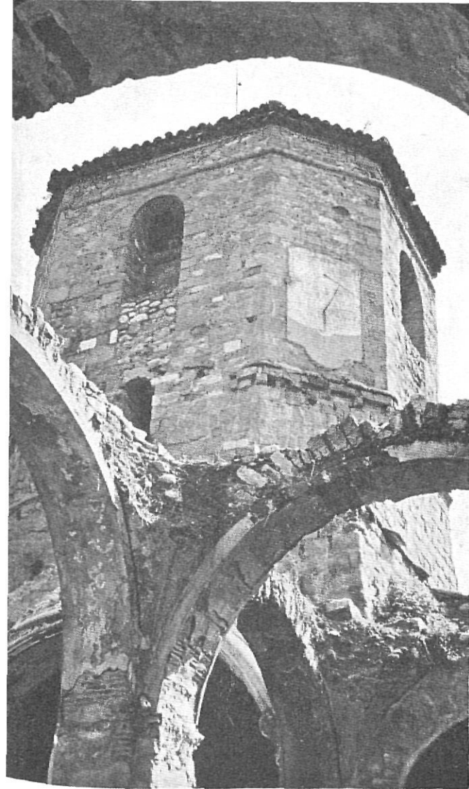
Estado al iniciarse las obras
