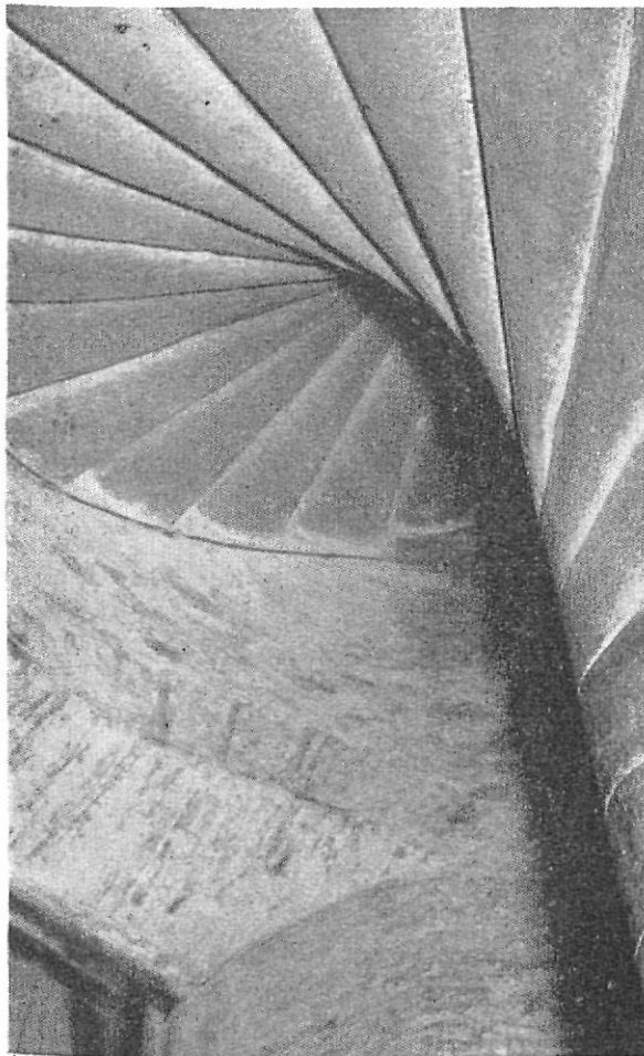
Detalle de la interesante escalera interior de la torre. Foto Moncanut.
