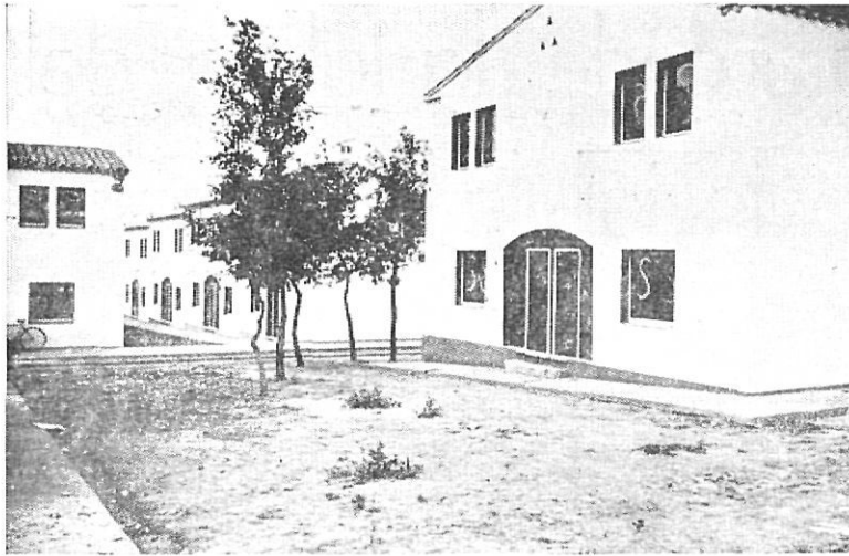
Viviendas recientemente terminadas que acaban de ser entregadas a sus destinatarios
