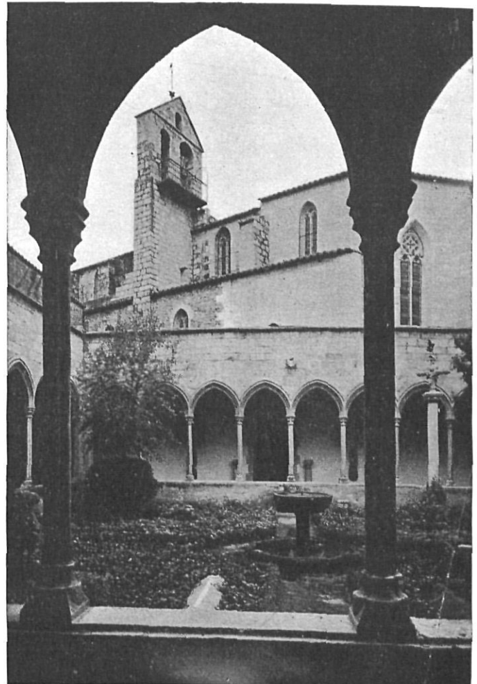
Campanario y claustro del Convento
