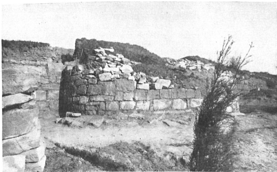
Poblado ibérico de Ullastret. — Angulo de la torre circular de la Muralla Frigoleta con el sector C-D de la misma muralla.
