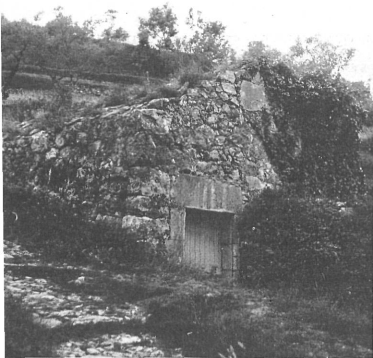
Caseta de distribución de las aguas, en Torre Gironella.
