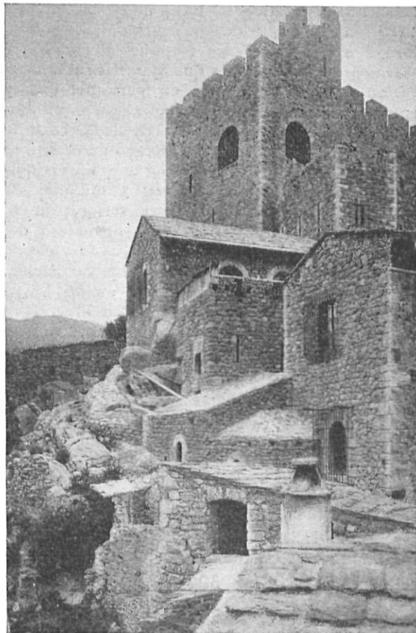
Estado actual de la fábrica del Castillo de Requesens.
